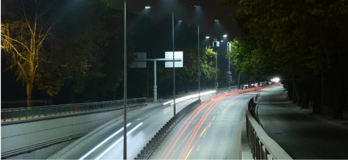
Ankara İnönü Bulvarı LED'li Yol Aydınlatma Pilot Projesi
